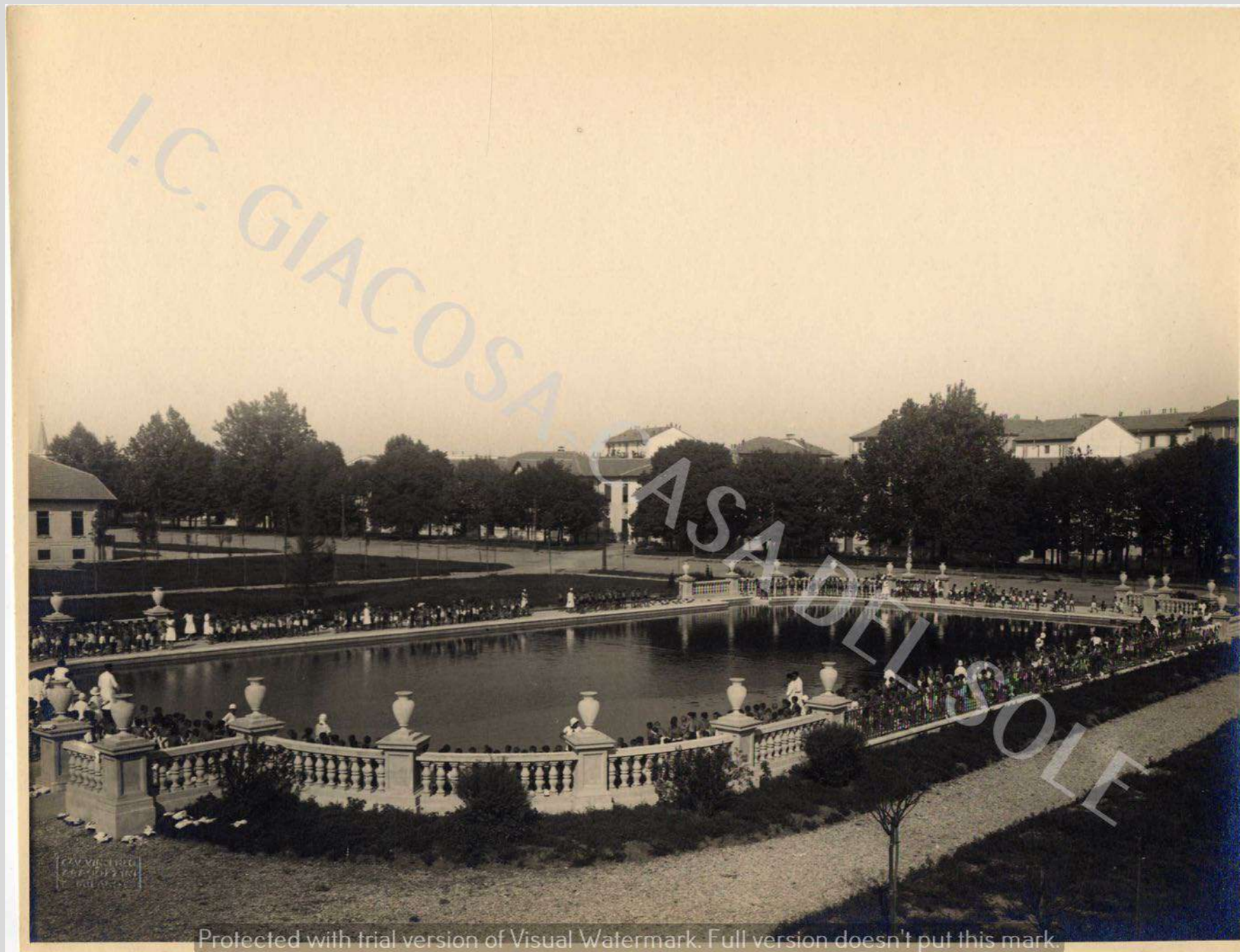
La piscina della Scuola all'aperto «U. di Savoia», 1929
